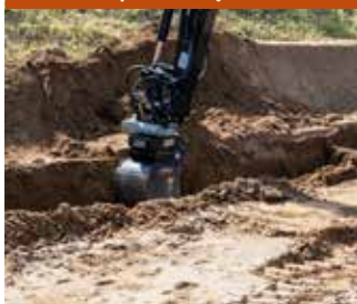
Wykop: Łyżka głęboka przesunięta
