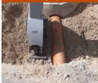
Zagęszczanie: Zagęszczarka do wykopów
