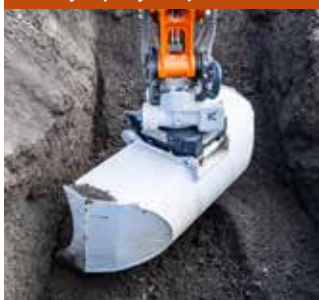
Wykop: Łyżka profilowa
